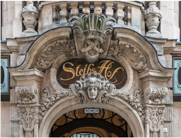
Detail des Sandsteinportals.
