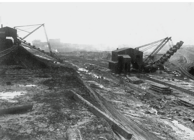
Montage des LMG Baggers III, 1915. © Archiv Ferropolis
