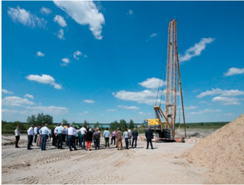
Sanierungsarbeiten am Speicher Borna zur Rutschungsprävention, 2021, © Andreas Berkner
