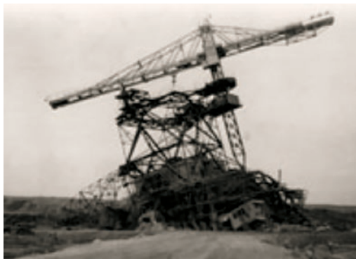
Die Kippenrutschung im Tagebau Haselbach 1977 mit Totalschaden am Absetzer 1037, © Sammlung Bergamt Borna
