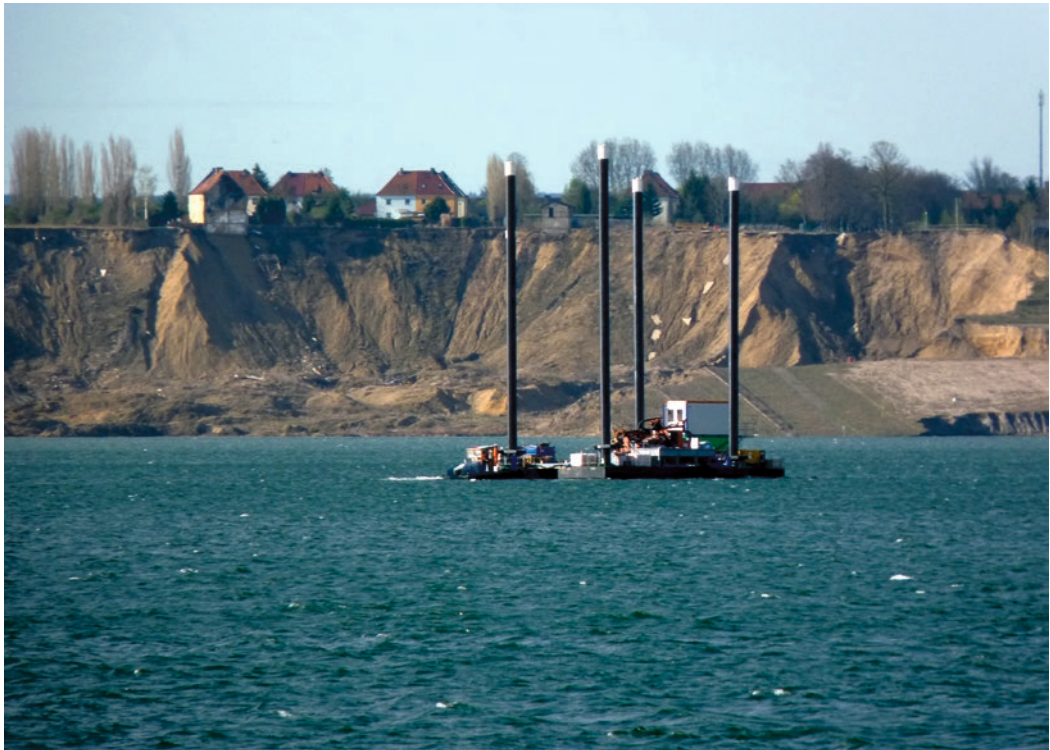
Rutschung Concordiassee Nachterstedt, 2009, © LMBV mbH
