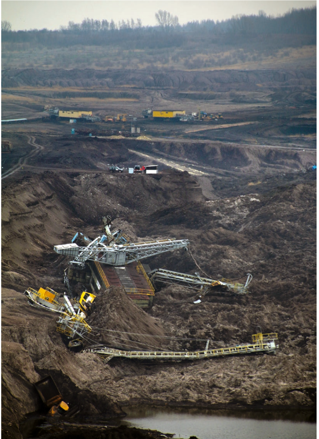
Rutschung Tagebau Amsdorf, 2014, © Andreas Berkner
