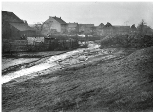
Rutschung von der Halde Trages in die gleichnamige Ortslage, 1958, © Sammlung Thomas Schmidt
