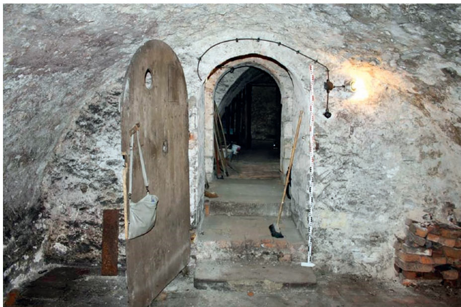
Abb. 52: Brauhauskeller im Hofbereich Markt 8 in Porphyrbuchstein
