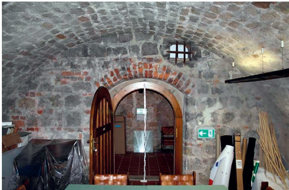
Abb. 44: Keller 5 des Rathauses in Sandsteinquadern
