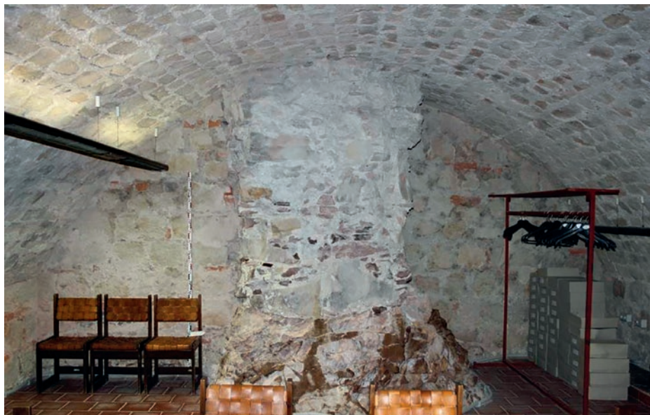
Abb. 42: Keller 4 des Rathauses mit Mauerwerkspfeiler der Nikolaikirche
