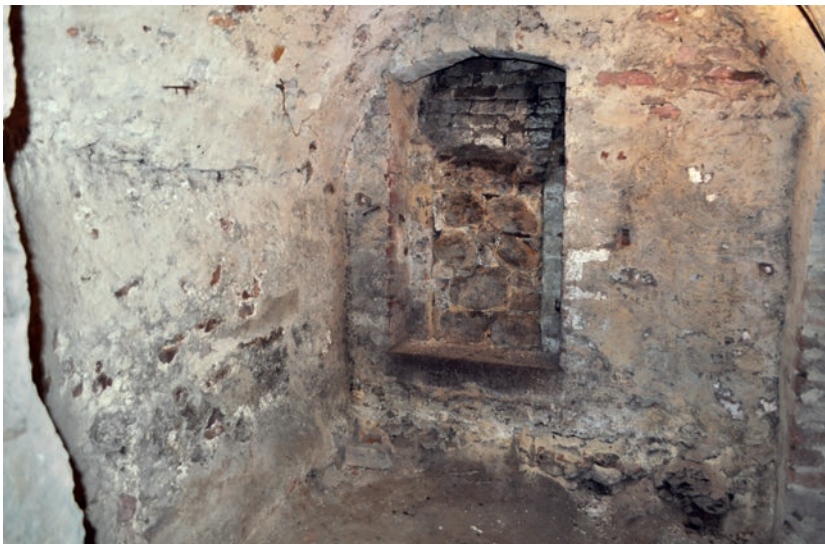
Abb. 47: Keller unter dem Markt 5 mit einer Fläche von 8 m 2 und 4,0 m Tiefe der Kellersohle, auf Fels gegründet, unter dem ehemaligen Rathaussturm (?), Porphyrbuchstein
