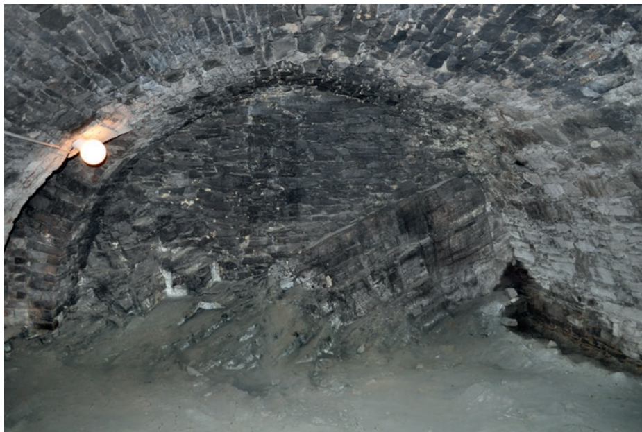
Abb. 32: Mittelalterlicher Porphybruchsteinkeller unter dem Wohngebäude Fischerstraße 11
