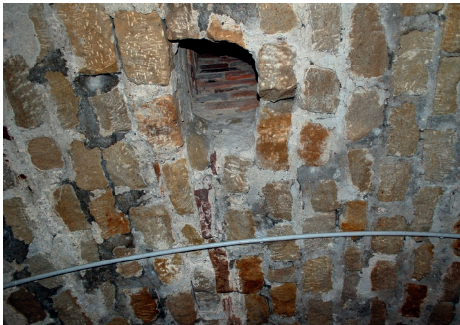
Abb. 36: Gewölbeöffnung für den Bierablass im Brauhauskeller von 1565, Fischerstraße 11
