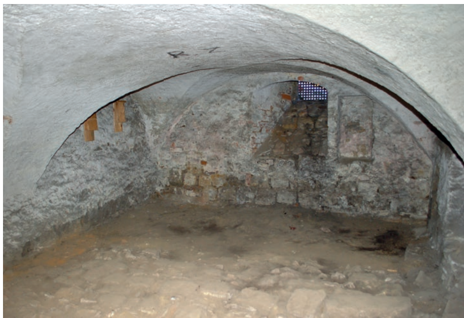
Abb. 33: Kreuzgratkeller der oberen Kellerzone unter dem Wohngebäude Fischerstraße 11
