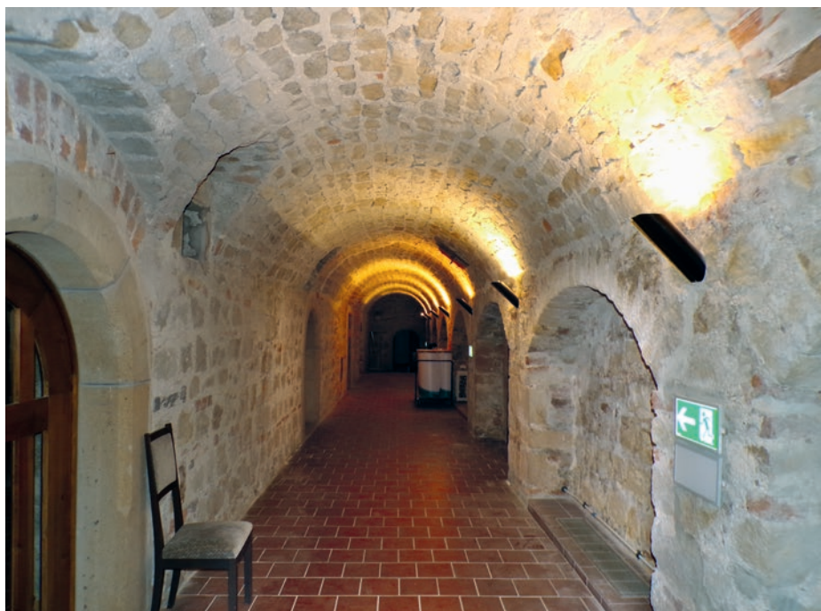
Abb. 43: Überwölbter Kellergang des Rathauses in Sandsteinquadern
