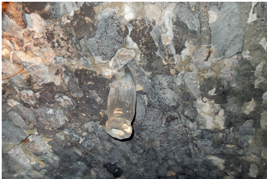
Abb. 31: Bierablauföhre im Vorderhauskeller Leipziger Straße 34
