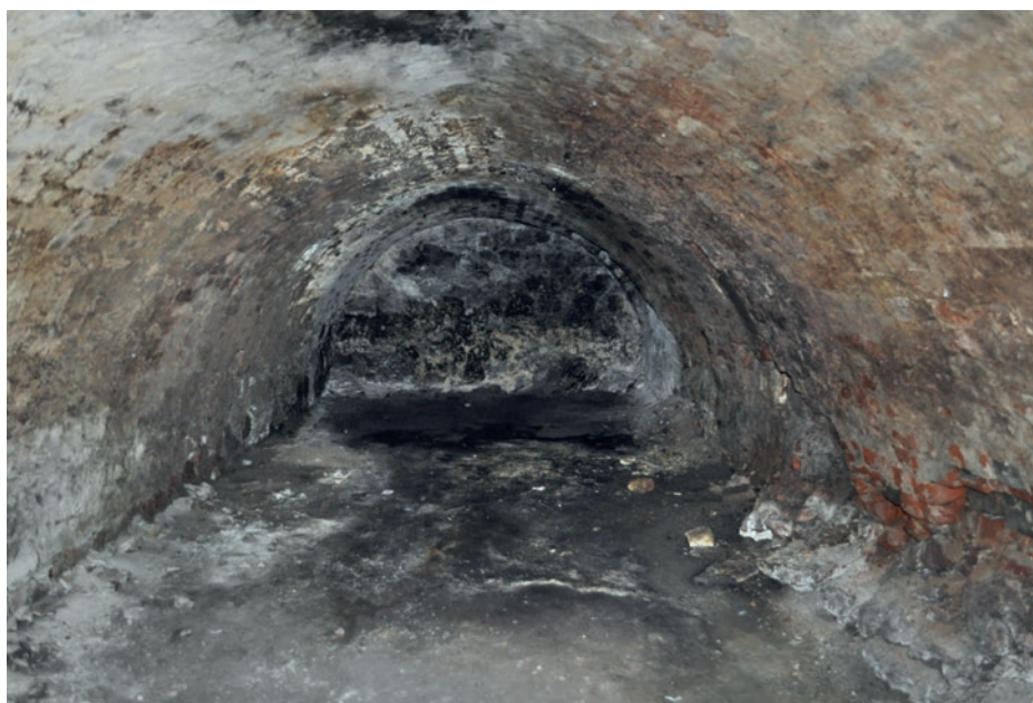
Abb. 49: Unterer Brauhauskeller (?) Markt 5, Kellersohle in 4,5 m Tiefe, Mischmauerwerk
