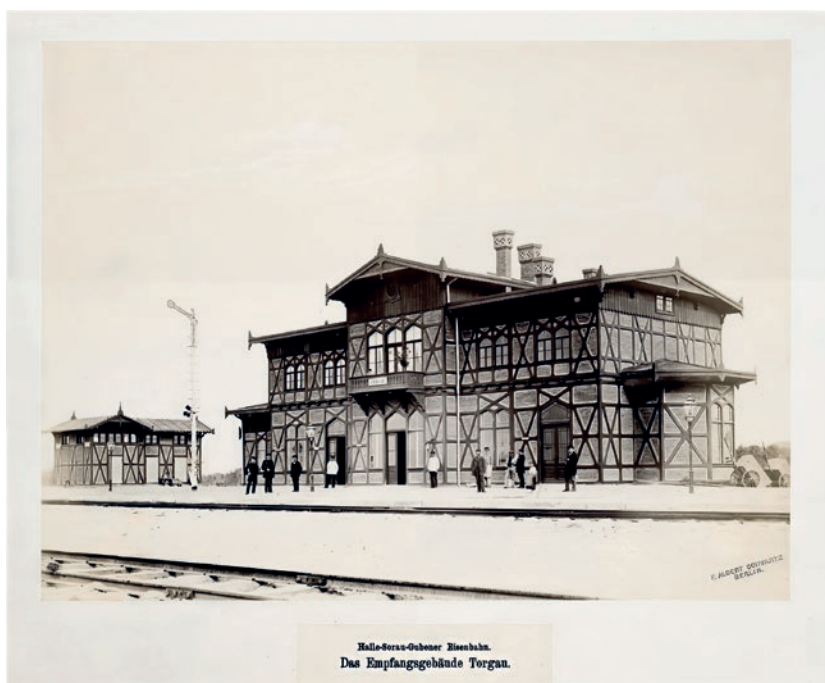
Abb 9: Bahnhof Torgau kurz nach der Fertigstellung. Links im Bild, das musste sein, das kleine Häuschen für »persönliche Bedürfnisse«. Die Eröffnung erfolgte am 1. Mai 1872.
