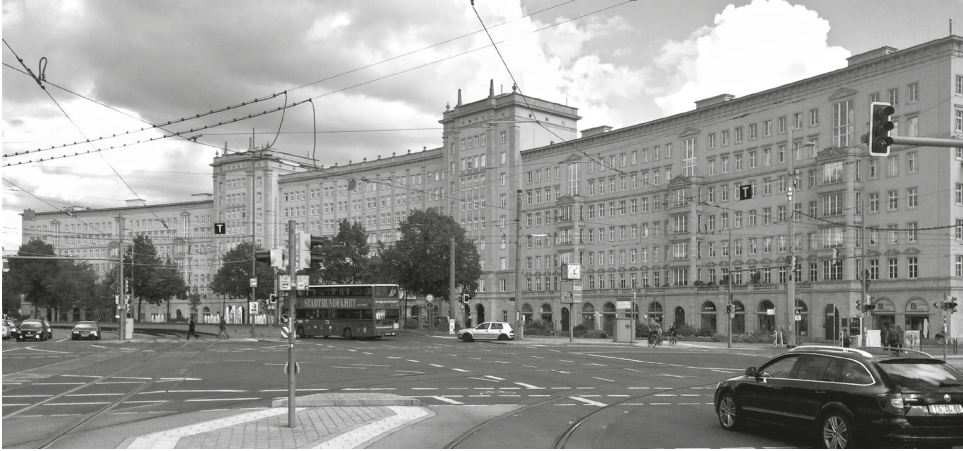
Abb. 6: Wohnbauten am Roßplatz, 2017 (Walter Lucas: Der Aufbau des Stadtzentrums von Leipzig , in: Deutsche Architektur 9 [1960], S. 474)
