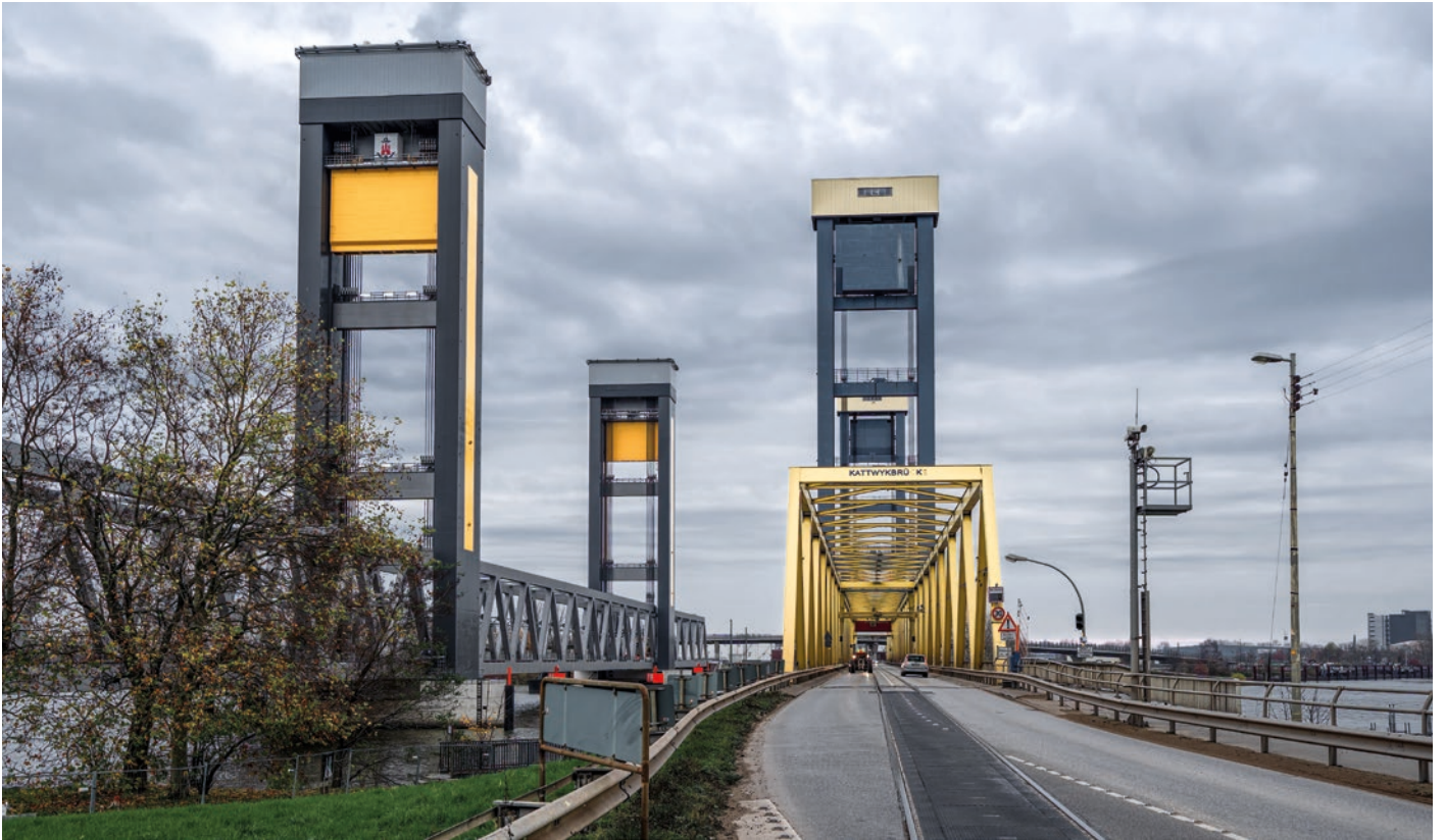
Hamburg – Kattwykbrücken – das sind zwei Hubbrücken über der Süderelbe (erbaut 1973 und 2020, Länge 290 m)
