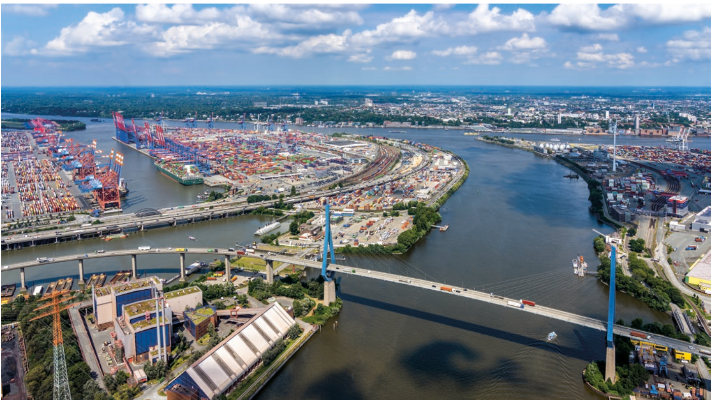
Hamburg – Kattwykbrücken – das sind zwei Hubbrücken über der Süderelbe (erbaut 1973 und 2020, Länge 290 m)
