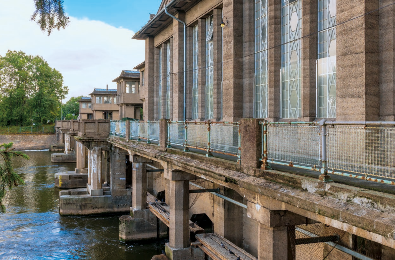
Wehrsteg bei Poděbrady (Podiebrad). Die Schleuse und das Wasserkraftwerk Poděbrady (Länge 97 m, Kulturdenkmal) vom Architekten Antonín Engel sind Teil der Elberegulierung und noch heute, 100 Jahre später, in Betrieb.
