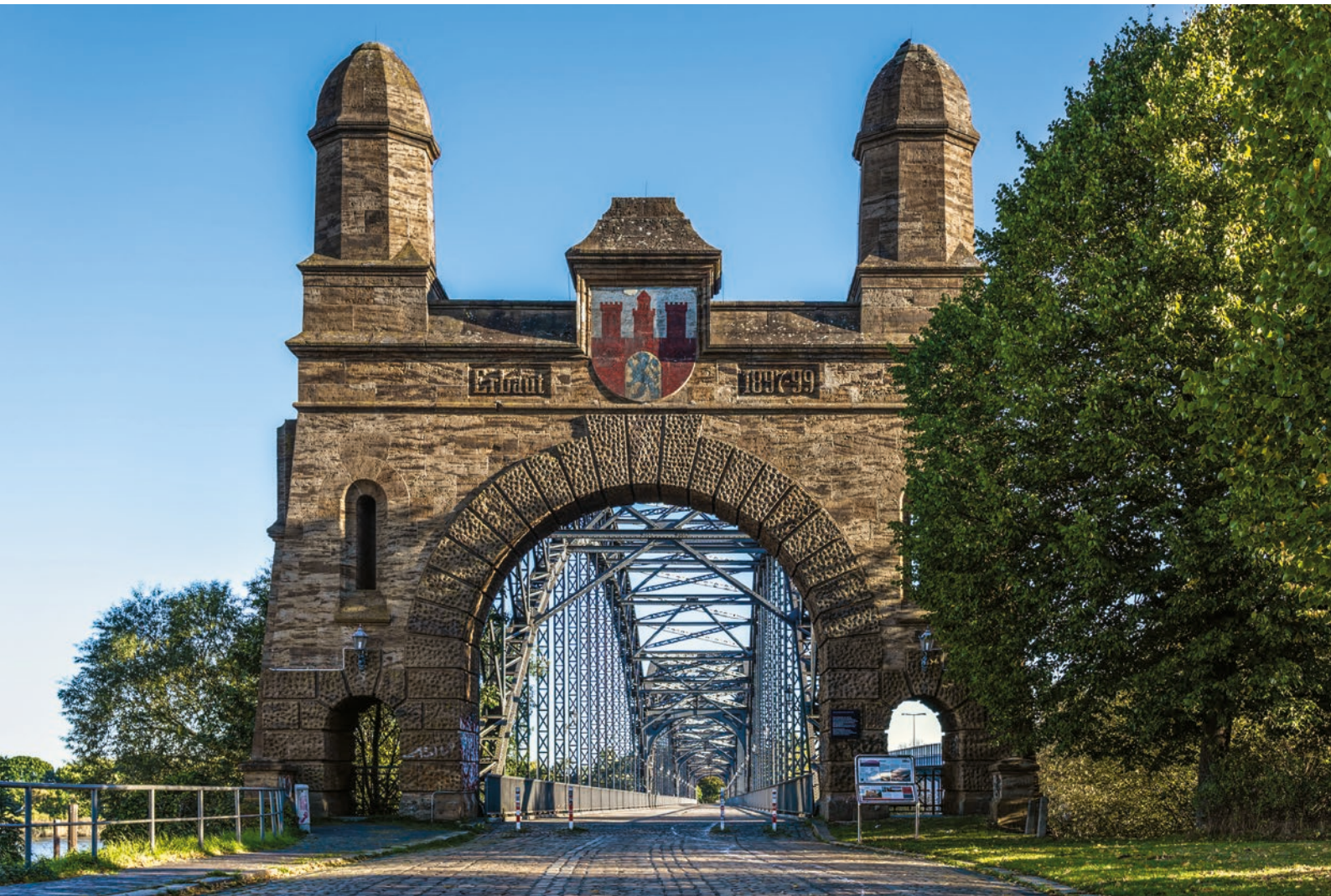
Hamburg – Alte Harburger Elbbrücke an der Süderelbe mit Sandsteinportalen, heute Weg für Fußgänger und Radfahrer (erbaut 1899, Länge 474 m)
