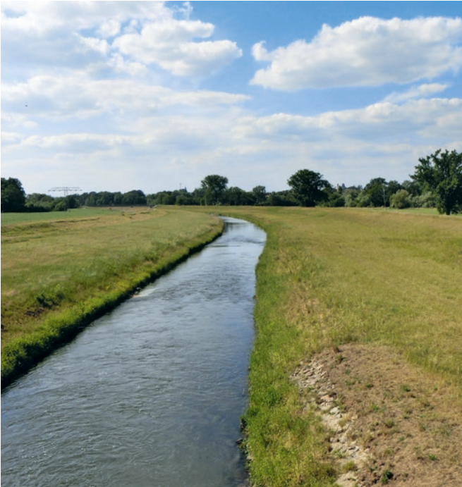
Die kanalisierte Luppe und der Elsterradweg in Höhe des Parkeingangs Lützschena
