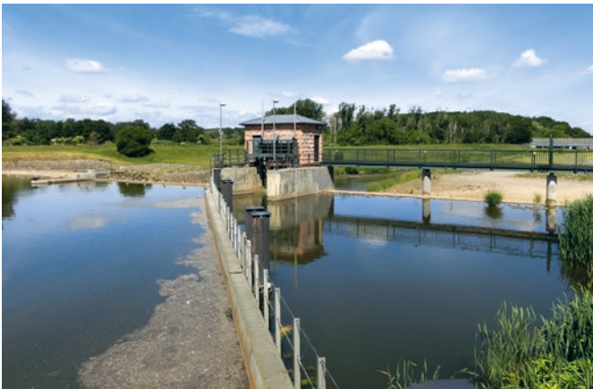
Am Luppewehr ausgangs des Elster- beckens
