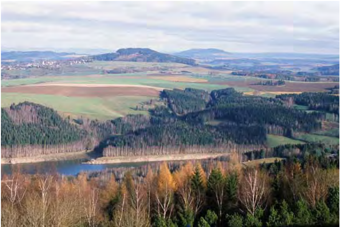
Blick vom Oberbecken Markersbach zum Scheibenberg und Pöhlberg
