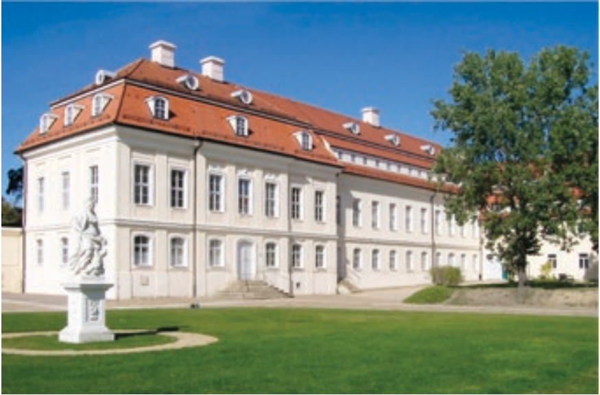
Ehemalige Gnadenwohnungen im Schloss Hubertusburg, Zustand 2013
