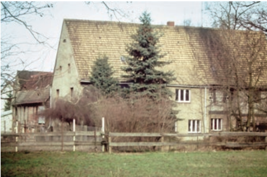
Zöllners Geburtshaus in Sorntzig, die ehemalige Lommermühle, Zustand 2002
