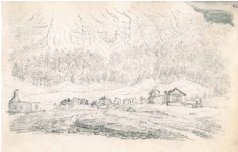
b) Skizzenbuch IV Blatt 62 – »Surlei (durch Muren fast zerstört)«, [Surlej, Gemeinde Silvaplana, Kanton Graubünden, Schweiz], undatiert (Juli 1869)
