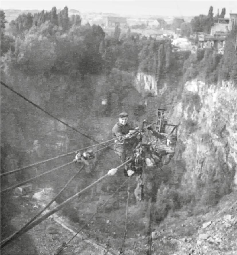
Abbildung 70: Reparatur oder Installationsarbeiten an der Kabelkrananlage im Steinbruch Döbitz. Blick nach Norden. Im Hintergrund die Werksanlagen des Steinbruches. September 1967.
