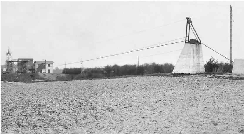
Abbildung 66: Blick über die Seilanlage des Kabelkrans der Fa. Bleichert im Hartsteinwerk Döbitz mit der südlichen Befestigung. Vermutlich 1920er Jahre.
