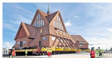
Im schwedischen Kiruna wurde die Kirche auf einem speziell konstruierten Wagen mit 224 Rädern für den Umzug mit einer Geschwindigkeit von einem halben Kilometer pro Stunde bewegt.
