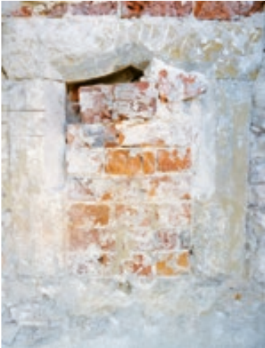
Schlosskapelle, Nordwand, Fenster des Vorgängerbaus, vgl. Abb. S. 121: Rechts neben der mittleren Fensterachse ist im neuen Putz die Lage der ehemaligen Fenster gekennzeichnet.
