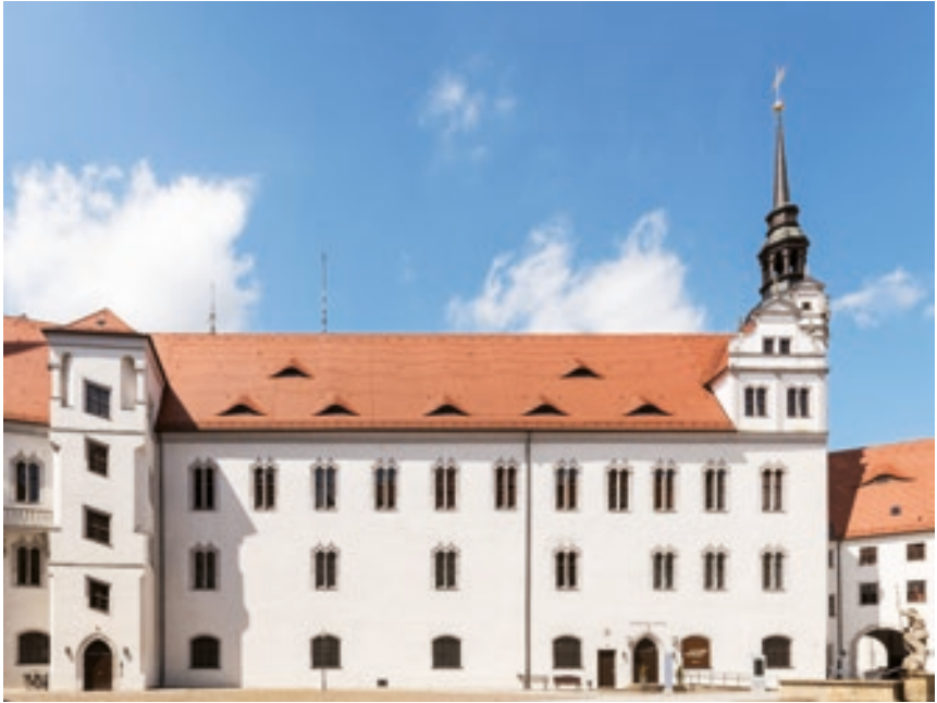
Albrechtbau (Flügel D), Ansicht vom Hof
