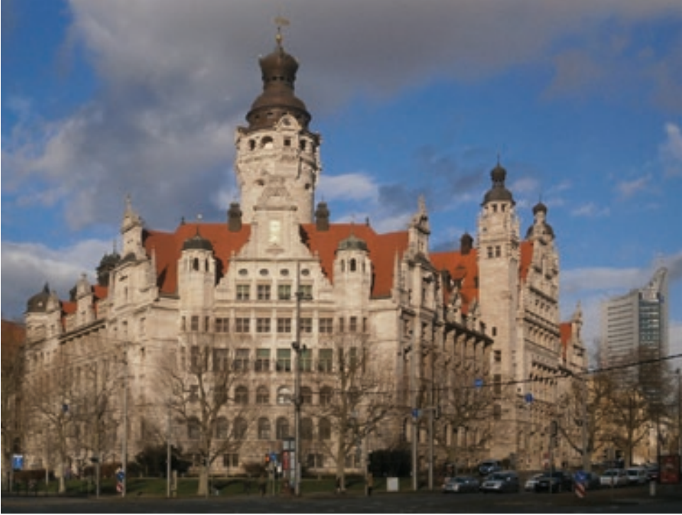
Abb. 1: Blick auf das Neue Leipziger Rathaus, rechts im Hintergrund das City-Hochhaus (Aufnahme Golo Ley).
