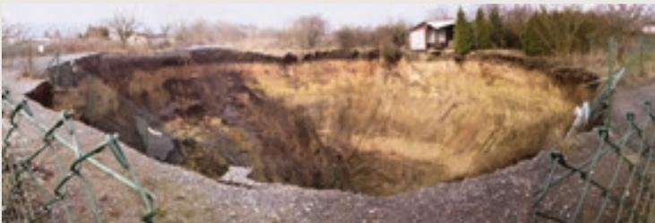
► Durch Karst und Kupferschiefer-Tiefbau bedingter Großerdfall in der Kleingartensparte Eisleben, Ortsteil Neckendorf. Der erstmals 1986 mit zehn Metern Durchmesser und sieben Metern Tiefe aufgetretene Einbruch wurde durch Nachbrüche im März 2003 auf 35 Meter Durchmesser und etwa zwölf Meter Tiefe erweitert.
