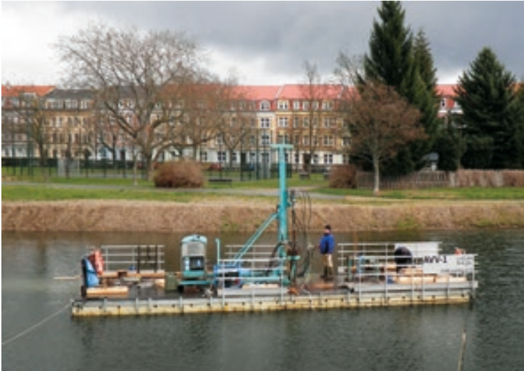
Baugrunderkundung am Schlossbergwehr
