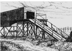
Abb. 34 Fördereinrichtung des um 1912 aufgeschlossenen Tagebaus der SEOK am Wachberg (Federzeichnung E. Würzner)
