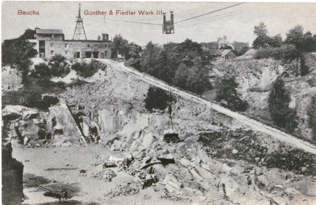
Das Werk III von Günther & Fiedler befand sich damals auf dem Gelände des heute stillgelegten sogenannten Tollert-Bruchs. Eine Schrägbahn führte zum Schotterwerk und über dem Bruch war eine Krananlage mit Laufkatze gespannt.
