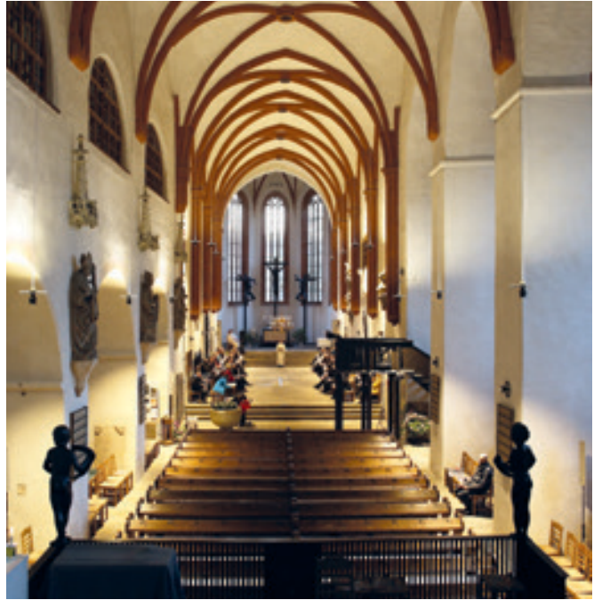
10 Gotische Wölbungsanfänger im Langchor, Aufn. 2014
