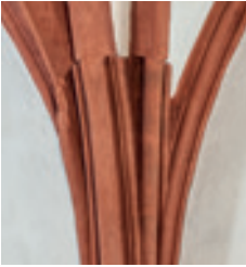
10 Gotische Wölbungsanfänger im Langchor, Aufn. 2014
