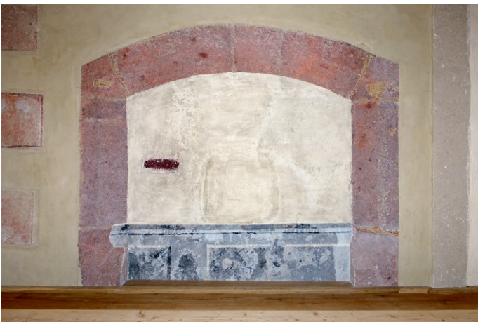
2 Bauzeitlicher Kamin mit der zweiten Renaissancefassung von 1588.
