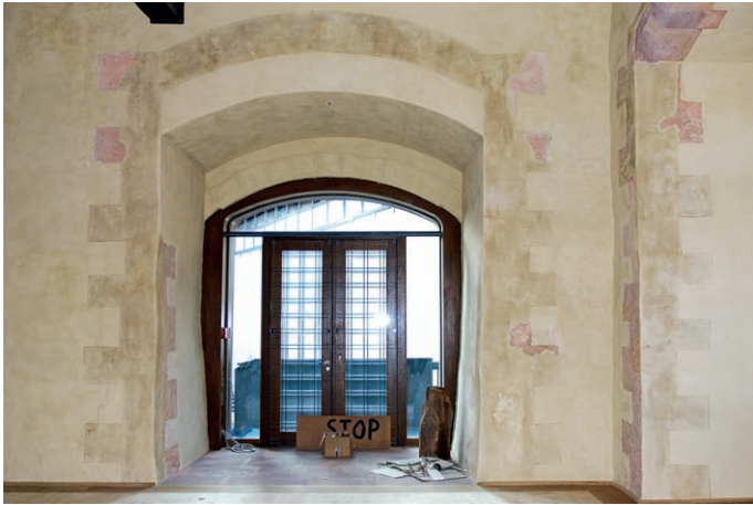
5 Westwand mit Befunden und rekonstruierten Bereichen der Quaderfassung in den Maßen der ursprünglichen Öffnung von 1475.
