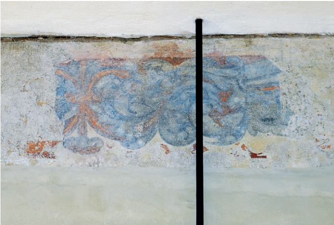
9 Erste Renaissancefassung von 1537 an der Ostwand der großen Tafelstube.
