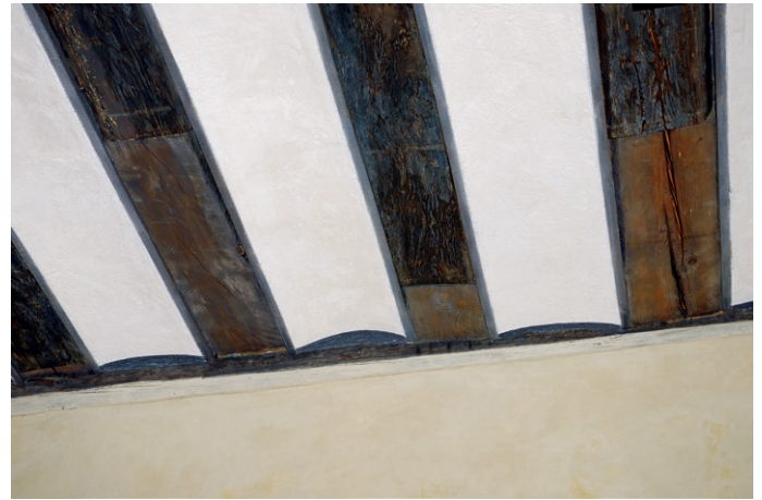
8 Deckenbereich nach Nord mit den rekonstruierten Balkenfüllungen von 1475, der weißen Kalkfassung und der schwarzen Rahmung.
