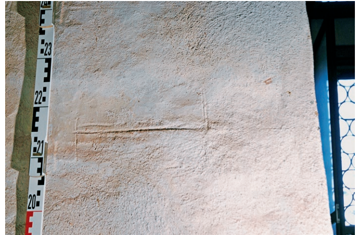
7 Vorrizung der Wandgliederung im frischen Putz an der Nordwand, 1475.
