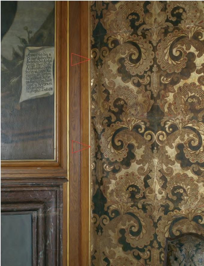
85 Wie hier in einem der sogenannten Augustzimmer im Schloss Moritzburg können die materialtypischen Dimensionsverluste des Leders als Reaktion auf zu niedrige Luftfeuchtwerte vor allem bei größeren Tapetenflächen zu einem vollständigen Ausreißen der Nagelkanten und anschließenden Deformationen führen. Demgegenüber ist die mechanische Belastung des Leders durch höhere Luftfeuchtwerte weitaus geringer.
